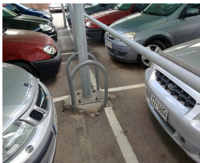
Προστασία Ιστών φωτισμού
