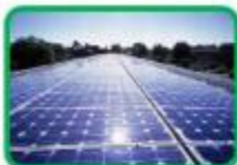
Φωτοβολταϊκα σε κατοικίες
